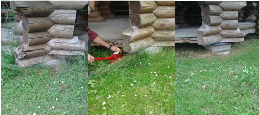
Die Hütte wurde angehoben und an den acht Stützen mit einer zusätzlichen Steinplatte und einer wasserundurchlässigen Folie unterbaut.
