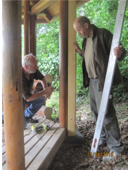
Stück für Stück werden die alten Blockhausteile entfernt und durch das neue Ständerwerk ersetzt.
